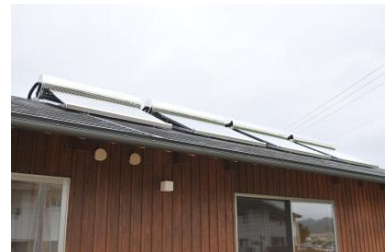
▲西棟の太陽熱温水パネル
